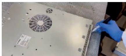
Segnare il perimetro del sistema sul retro del top cucina. Mark the perimeter of the system on the back of the slab.
